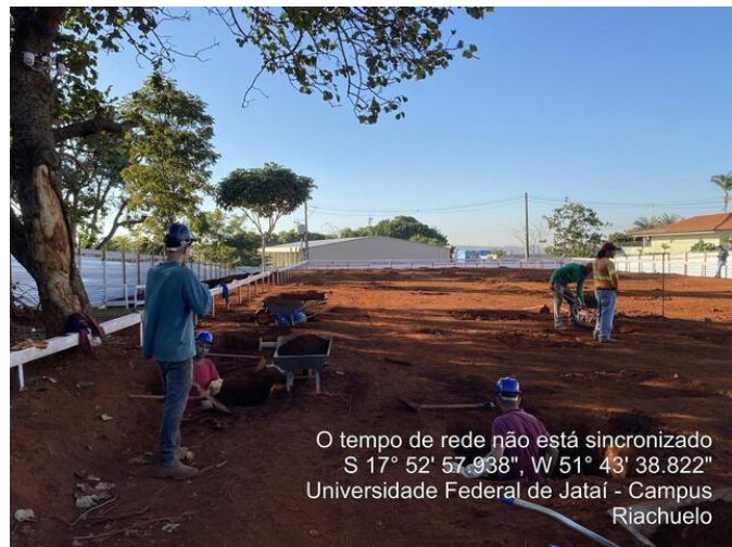
Gabarito danificado por causa da entrada do caminhão
