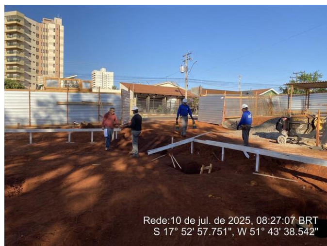
Gabarito danificado por causa da entrada do caminhão
